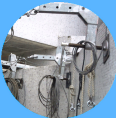
按照有關大廈之需求安裝吊船。
