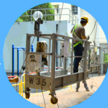
安裝吊船後，進行適當之調試。
